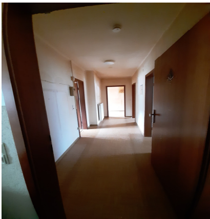
Rückbau DG-Wohnung Zeppelinstr. 7
