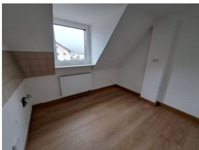
Wohnungssanierung Schaffhauser Str. 46 DG
